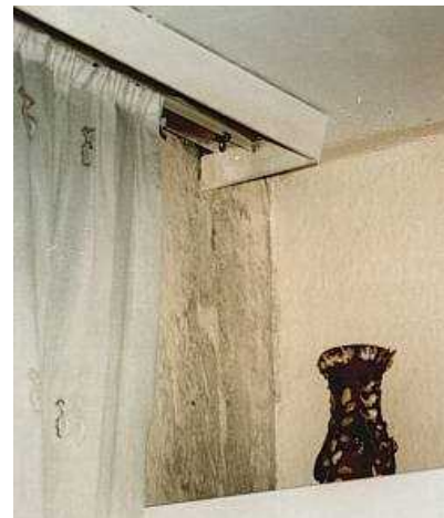
Verdachtsmoment: Wärmebrücke
