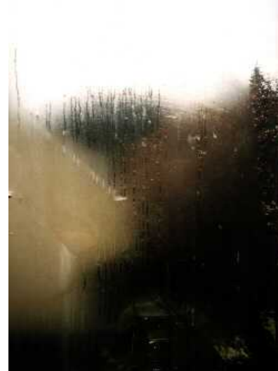
Kondenswasserbildung am Küchenfenster
