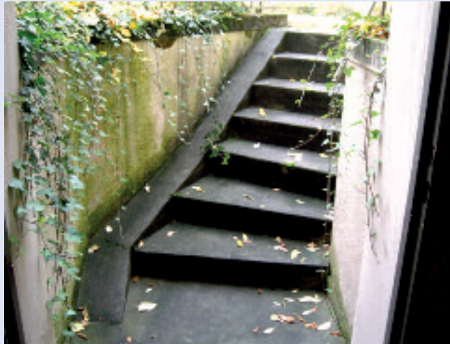
Das ist weder eine „Rampe“ noch eine „Treppe“ im Sinne des Mietspiegels
